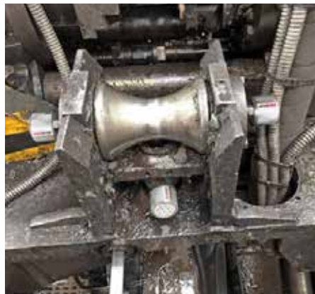
昇降装置のガイドローラ部へのシマルーベ30の取付事例
